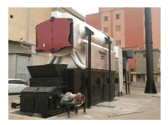
Su borulu primer yanma odasının altına monte edilen konveyör ızgaralı yakma ünitesidir.
